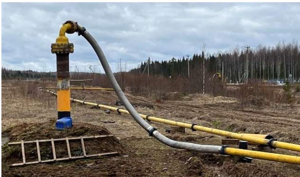
Рисунок 3 – Временная линия из трубопроводов с БРС
