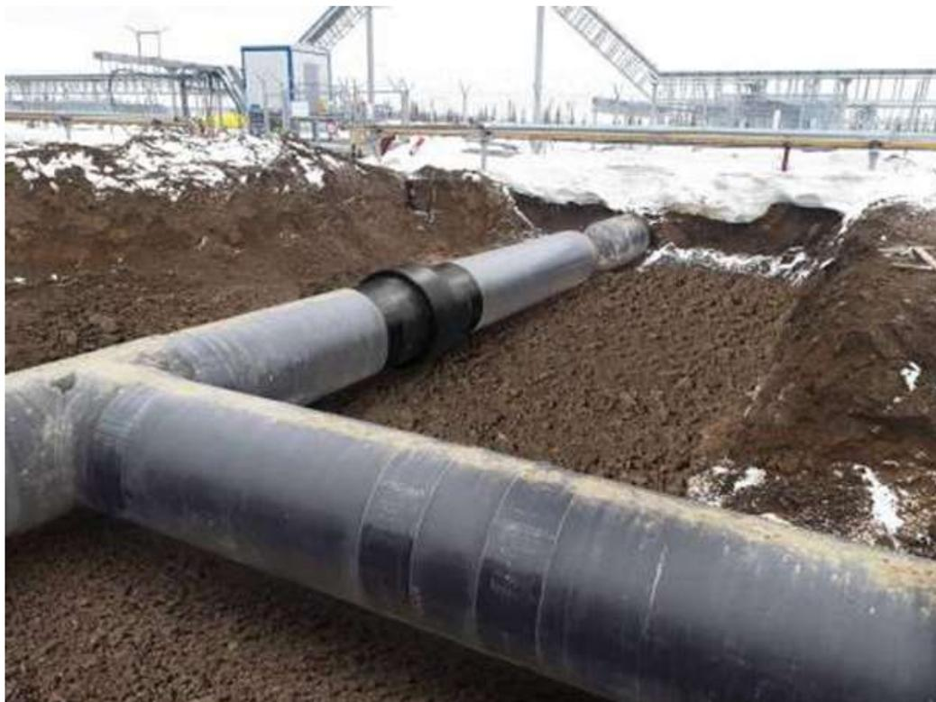
Рисунок 6 – Установка ВЭИ на газопроводе диаметром 1420 мм
