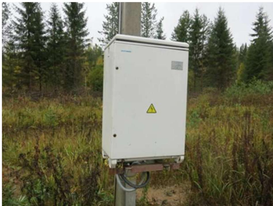
Рисунок 7 – Временная станция катодной защиты
