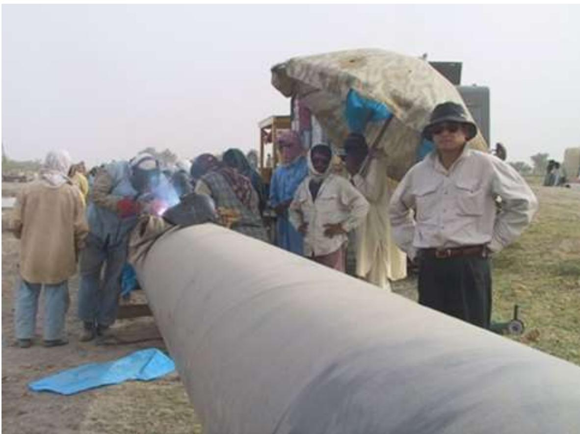
Рисунок 1 – Сварка металлическим электродом в защитной атмосфере
